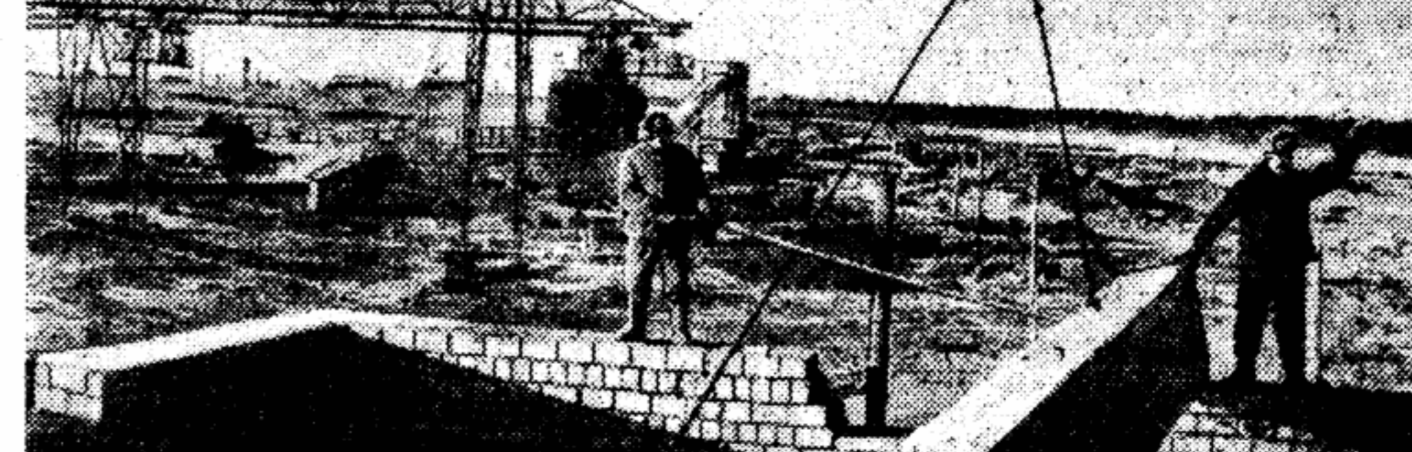
Общий вид строительства Назаровской ГРЭС.
